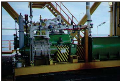
Компрессор NASH 2BG на морской буровой платформе
